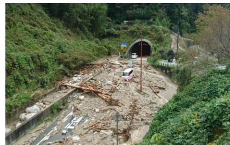
大雨により被災した国道309号
