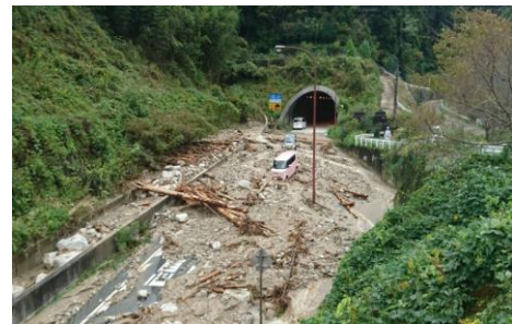
大雨により被災した国道309号
