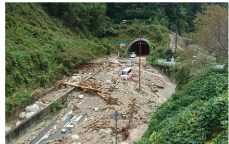
大雨により被災した国道309号
